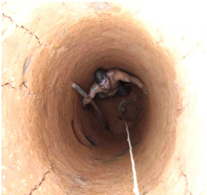
Escavando o poço e construindo o futuro (Fonte: Raúl Cháves)
